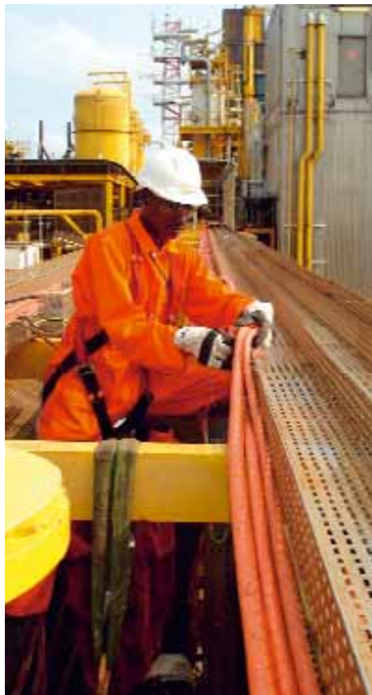
Tirage de câbles en mer.
